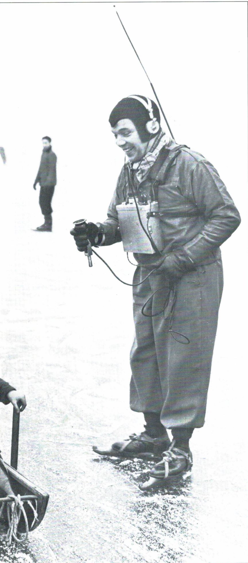
Dick van Rijn op lokatie met de VHF-zend/ontvanger. Bij de NRU noemde men dit apparaat 'Het Bokketuig'.
